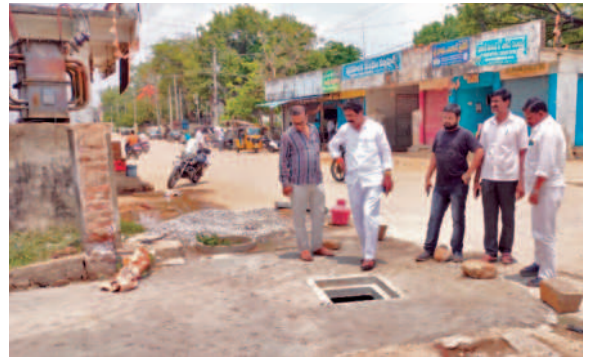
డ్రైనేజీ పనులను పరిశీలిస్తున్న మున్సిపల్ చైర్మన్ అశోక్ గౌడ్ తదితరులు
